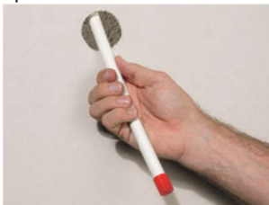
Фигура 21: Винаги защитавайте краищата на тръбите
